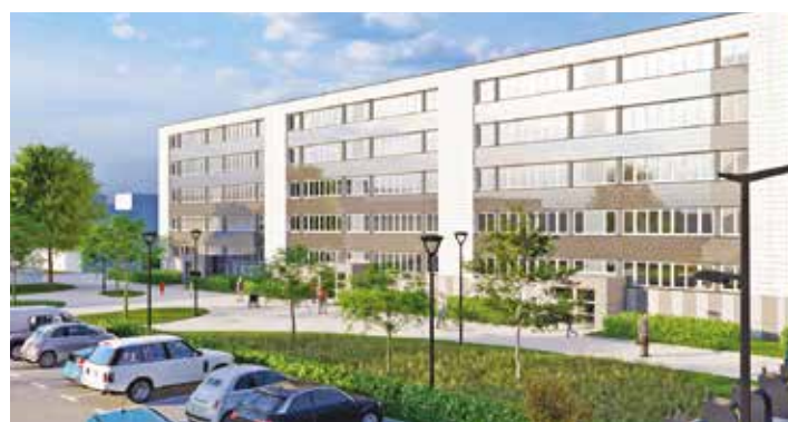
Pas-de-Calais Habitat a lancé les travaux de réhabilitation de la résidence Luxembourg.
